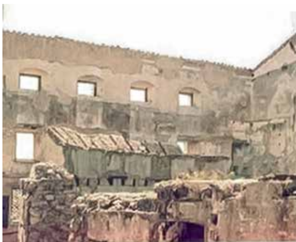
Figura 8. Estado del Teatro Gabriel y Galán de Trujillo antes de la rehabilitación (ZORITA CARRERO, J.R., 1986).
