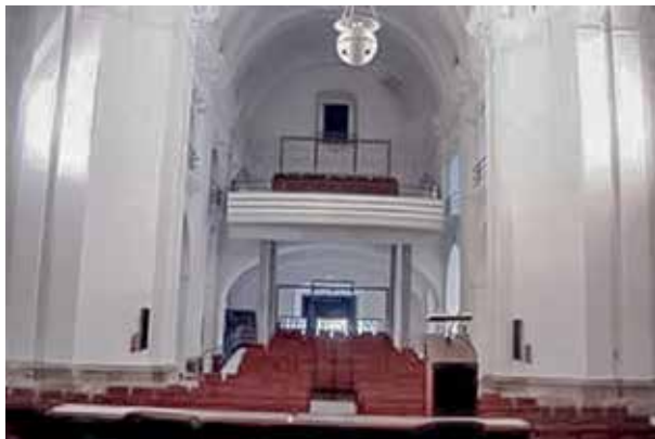
Figura 6. Nave central y crucero del Centro Cultural la Merced de Llerena tras la rehabilitación (Fotografía de la autora).
