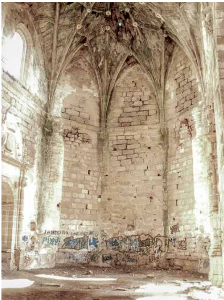
Capilla mayor. Iglesia del Convento de San Antonio de Padua. Garrovillas de Alconétar (Foto: Jose María Velaz)
