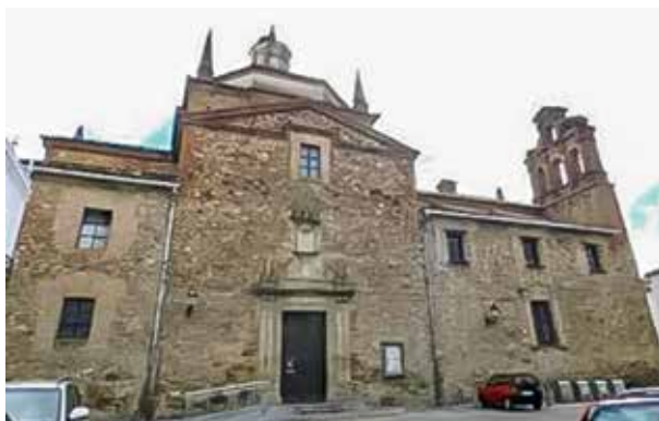
Figura 4. Fachada del Centro Cultural la Merced de Llerena (Fotografía de la autora).
